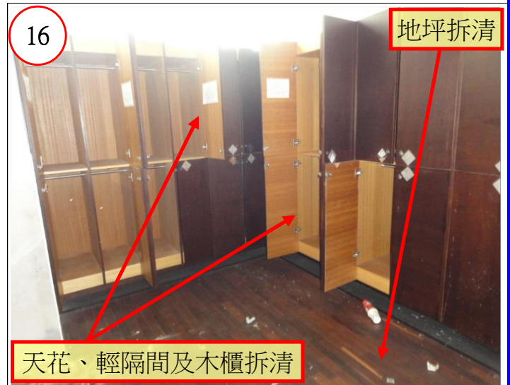
暗架天花、木作、輕隔間牆、地坪及木櫃拆清
