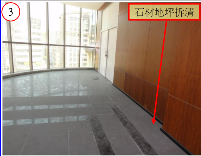
石材地坪拆清(統一至PC面)
