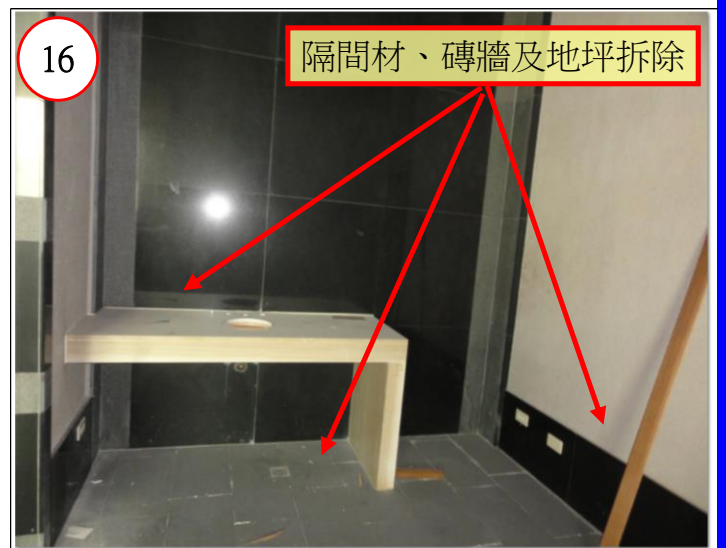
隔間材、磚牆及地坪拆清
