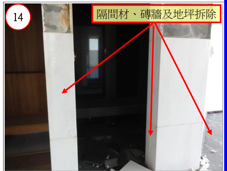
隔間材、磚牆及地坪拆清
