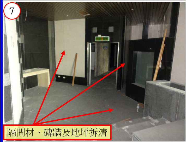
隔間材、磚牆及地坪拆清
