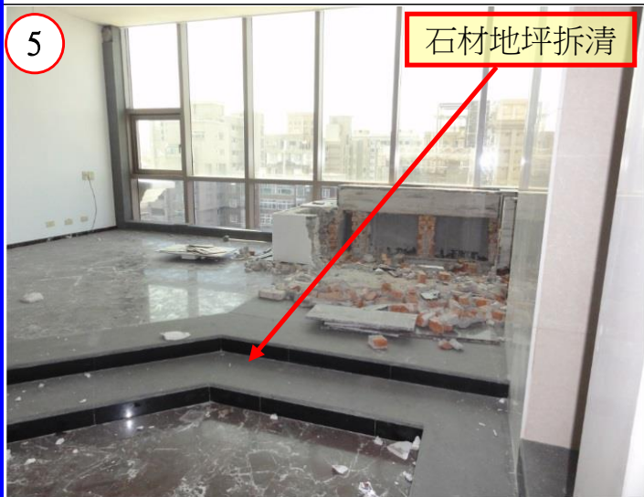
石材地坪拆清(統一至PC面)
