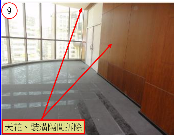
暗架天花、木作、輕隔間牆拆清
