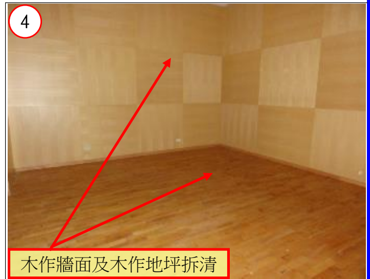
木作牆面及木作地坪拆清
