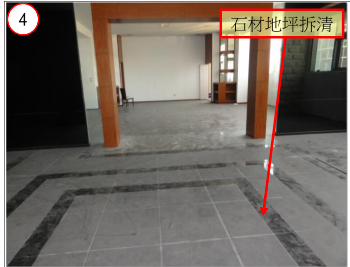
石材地坪拆清(統一至PC面)
