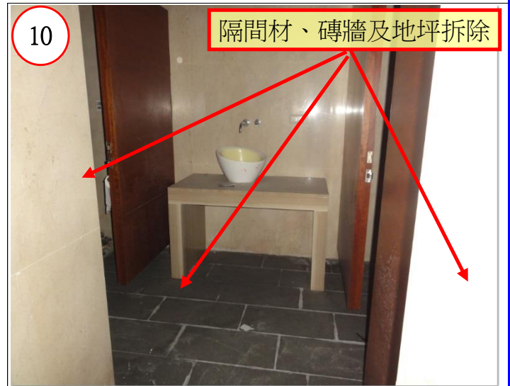
隔間材、磚牆及地坪拆清
