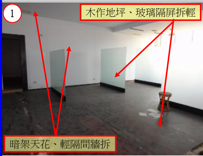
暗架天花、木作、輕隔間牆及玻璃隔屏拆清
