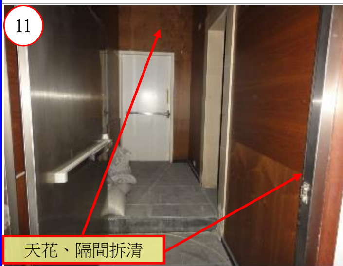
暗架天花、木作、輕隔間牆拆清
