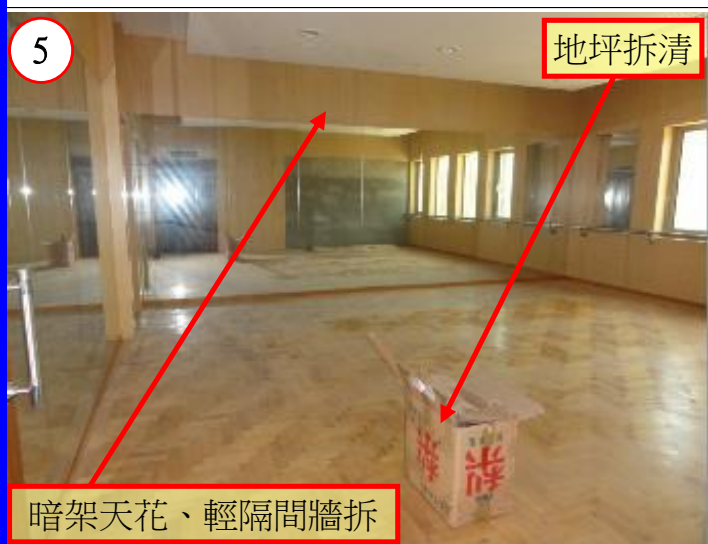
暗架天花、木作、輕隔間牆及玻璃拆清
