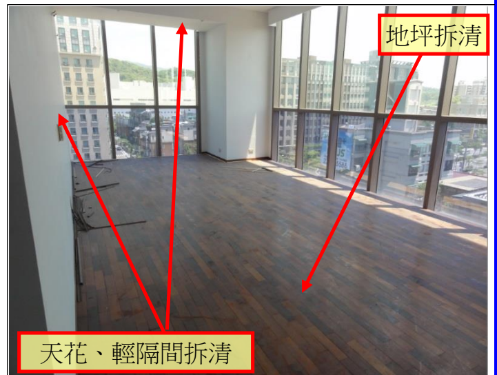
暗架天花、木作、輕隔間牆、地坪拆清
