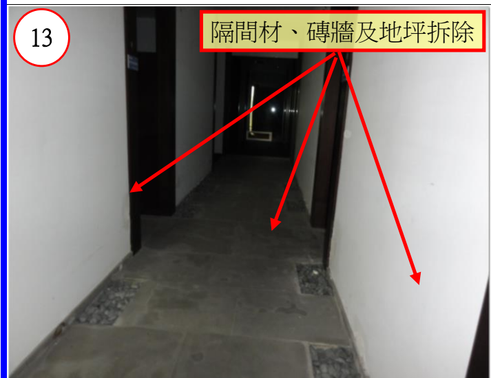
隔間材、磚牆及地坪拆清
