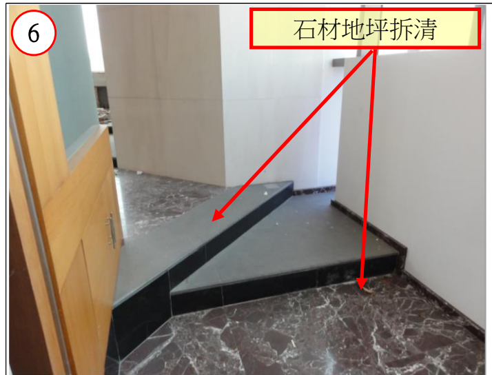
石材地坪拆清(統一至PC面)
