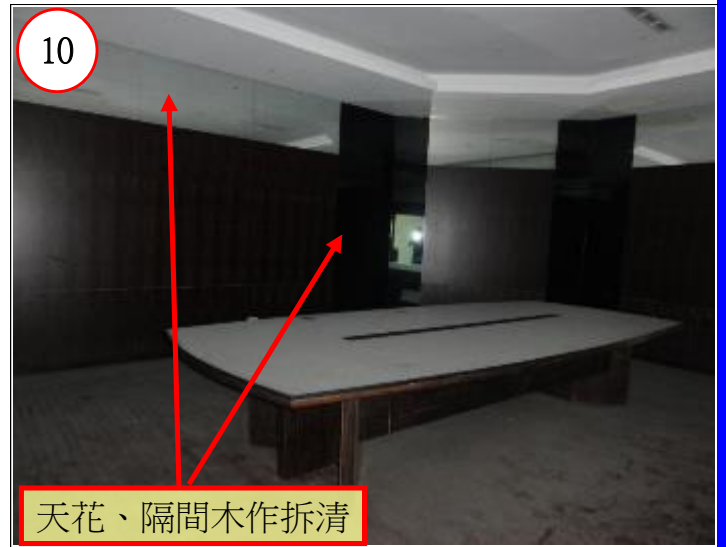
暗架天花、木作、輕隔間牆拆清
