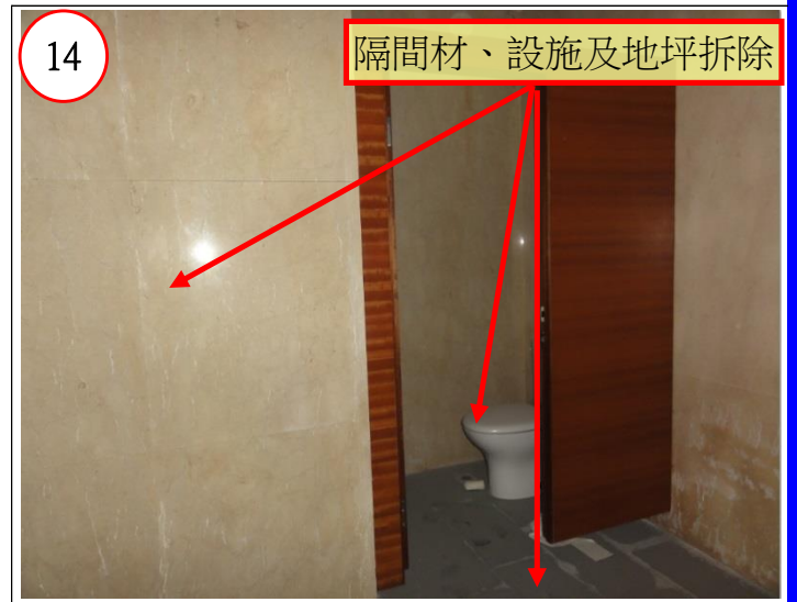
隔間材、磚牆、設施及地坪拆清
