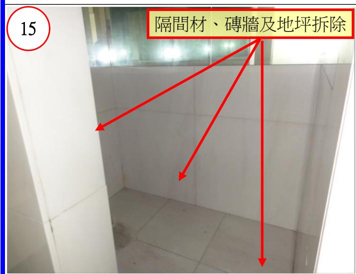
隔間材、磚牆、設施及地坪拆清
