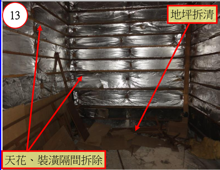
暗架天花、木作、輕隔間牆拆清(烤箱)
