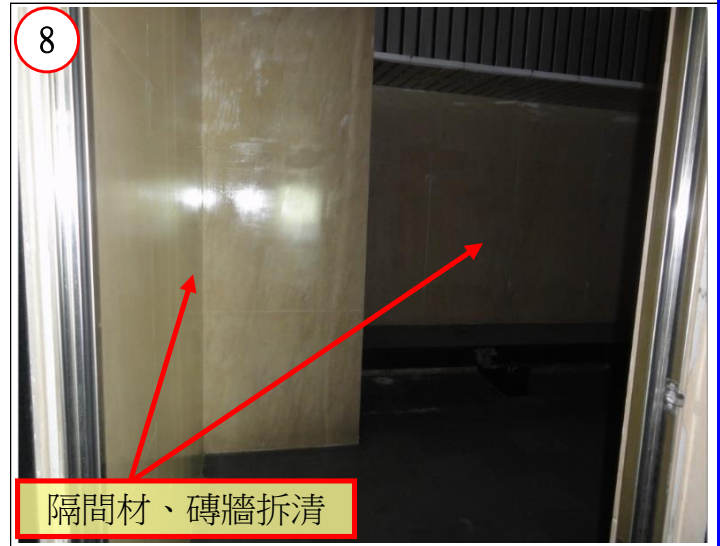
隔間材、磚牆及地坪拆清
