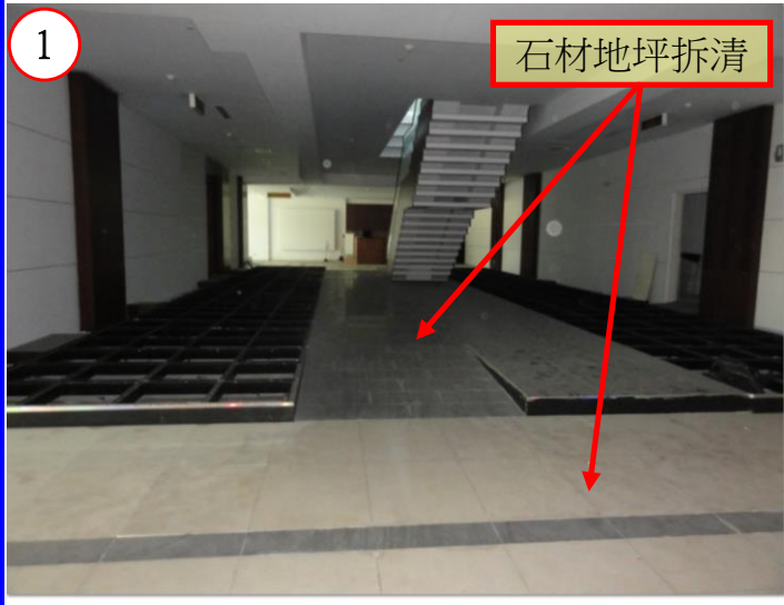
石材地坪拆清(統一至PC面)
