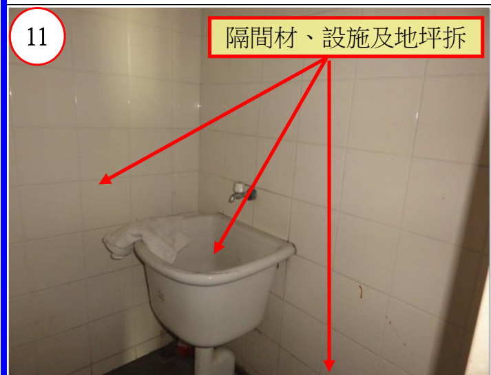
隔間材、磚牆、設施及地坪拆清
