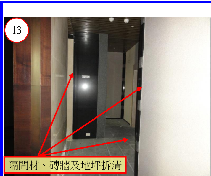
隔間材、磚牆及地坪拆清
