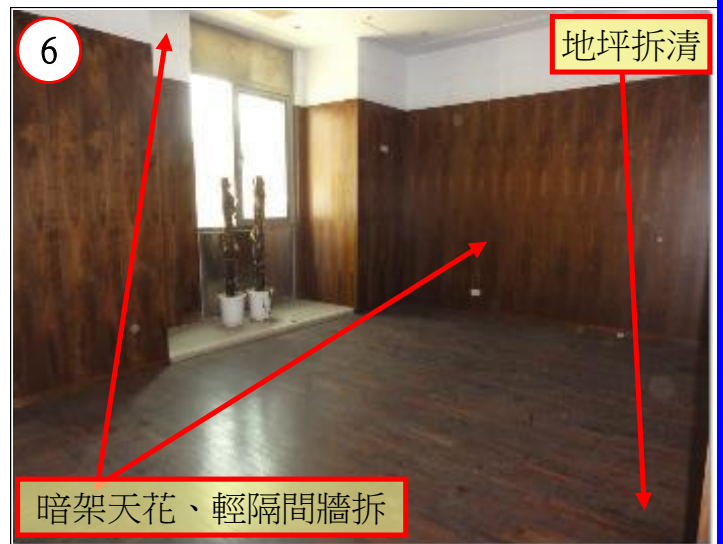
暗架天花、木作、輕隔間牆及玻璃拆清
