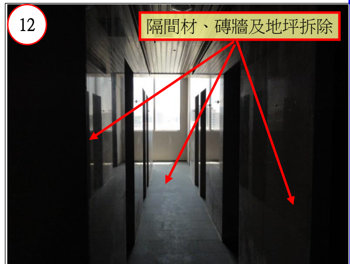
隔間材、磚牆及地坪拆清
