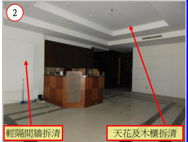
暗架天花、木作、輕隔間牆及雜物拆清
