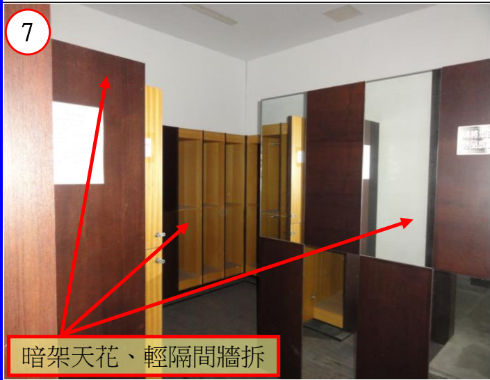
暗架天花、木作、輕隔間牆及木櫃拆清
