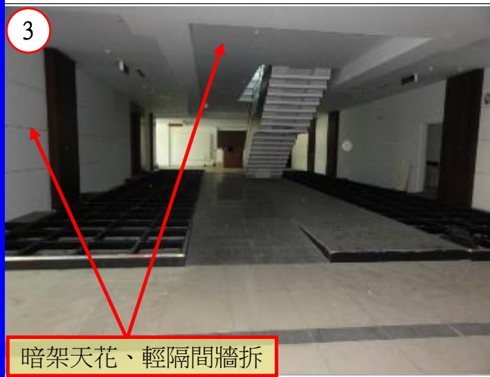
暗架天花、木作、輕隔間牆拆清
