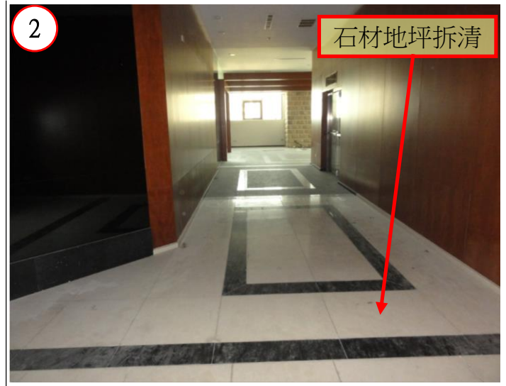
石材地坪拆清(統一至PC面)
