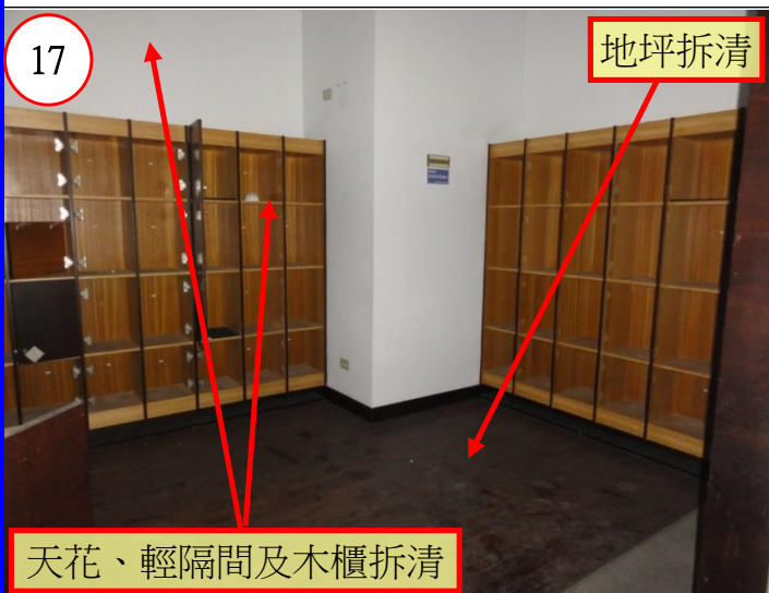
暗架天花、木作、輕隔間牆、地坪及木櫃拆清
