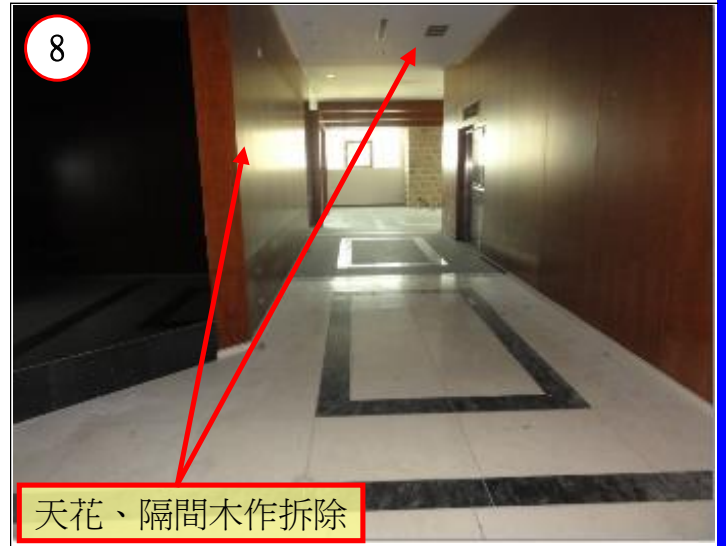
暗架天花、木作、輕隔間牆拆清
