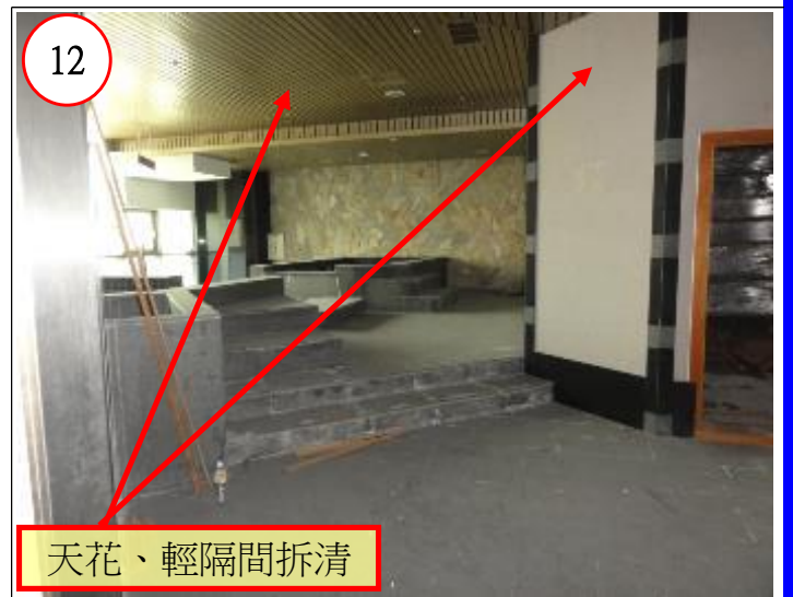
暗架天花、木作、輕隔間牆拆清
